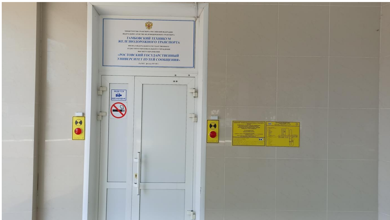
Входная дверь в главный корпус – Вход № 1
